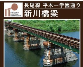
●長尾線平木一学園通り間の橋梁で、明治44年に竣工された。橋脚の流線形の輪郭と、複線化を見込んだ階段状の石積みが特徴。
