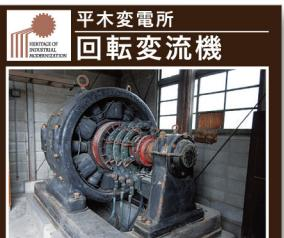
●昭和37年に国鉄から譲渡された。交流電気を電車のモーター用に直流電気に変換する装置の初期のものが回転変流機である。
