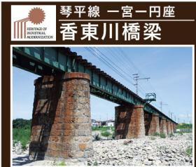
●大正15年に竣工され、記念碑性の橋長はことでの第2位の規模。「ボルタル構造式四角鉄柱」は、開業当初の架線鉄柱である。
