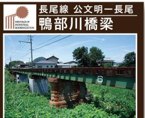
●明治44年に竣工された長尾線公文明一長尾間の鉄橋で、当時路線複線化に備えて、橋脚の石積が階段状になっていることが特徴。
